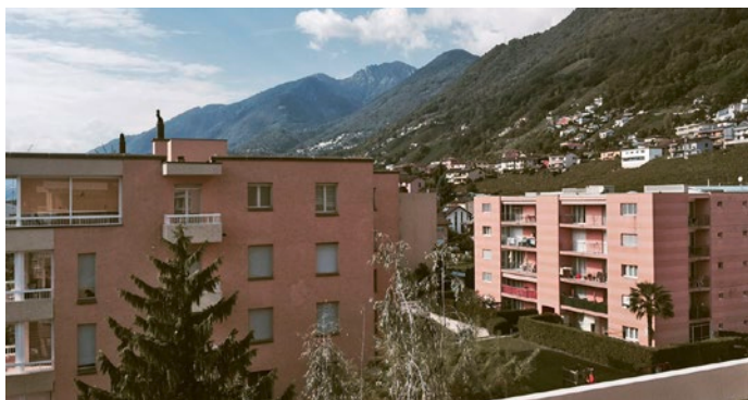
Wohnüberbauung «Via Francesca 6a, b, c» in Gordola
