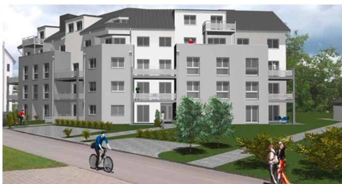
Complesso residenziale «Im Brüel 6 e 6a» a Sirmach
