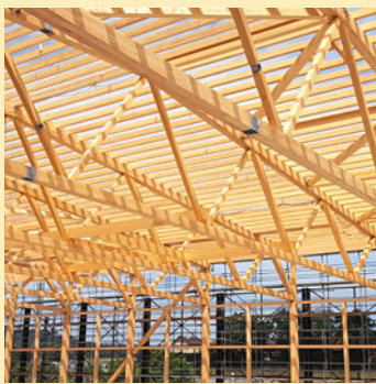
Eishalle Pruntrut – Hauptstützen und Träger im Anbau und auf den Tribünen
